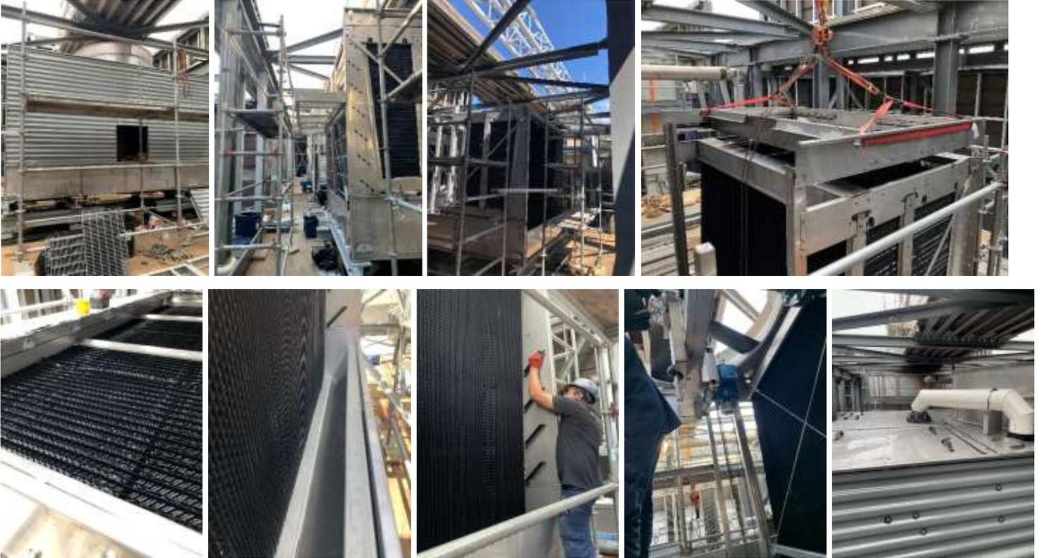
**Travaux.** Assemblage de la partie supérieure de la nouvelle tour (panneaux, *distribution d'eau et surfaces*).
