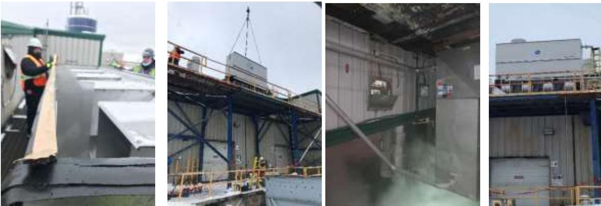
**Travaux.** Ajout de joints d'étanchéité, mise en place de la partie supérieure modification de la tuyauterie, et finition.
