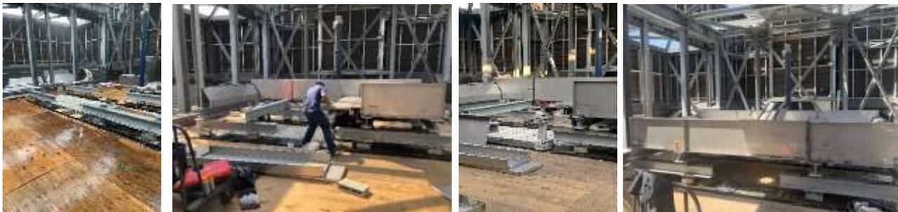
**Travaux.** Assemblage de la partie inférieure de la nouvelle tour (structure, plancher et bassin).
