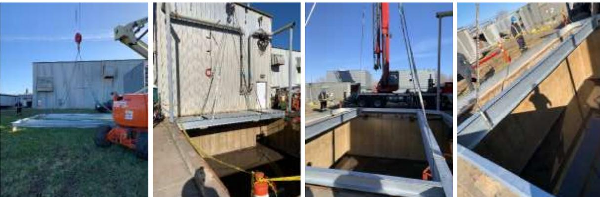
**Travaux.** Remplacement de la structure de support des tours d'eau
