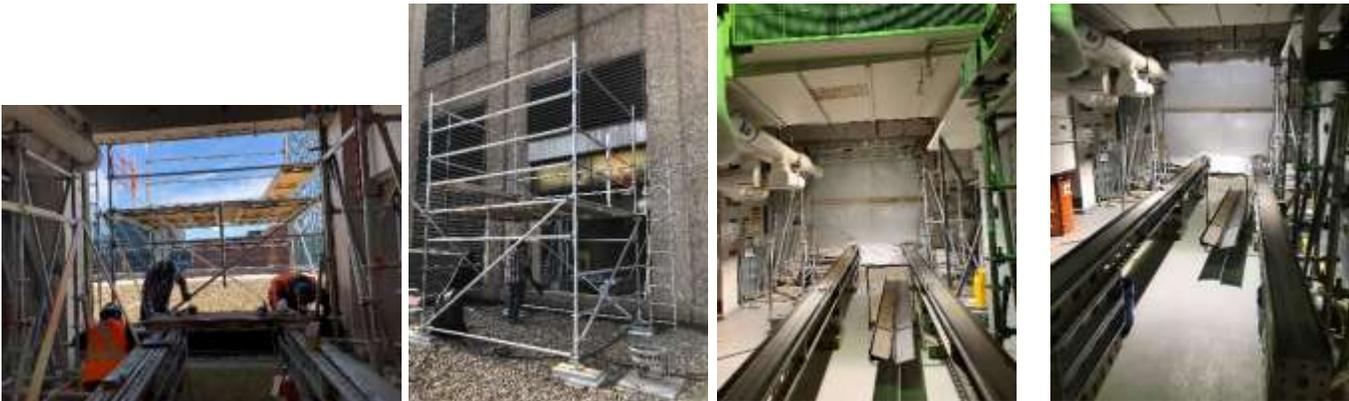
**Travaux.** Construction d'échafaudages sur rails pour la réception et le transport du serpentin
