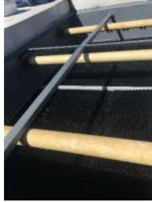
**Travaux.** *Installation de la nouvelle surface d'échange*
