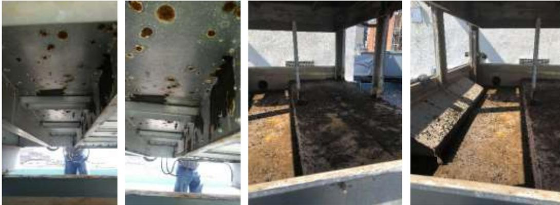
**Avant.** Panneaux existants présentant des signes de corrosion et d'*usure*.
