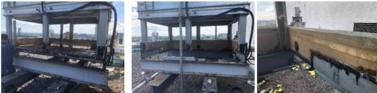
**Travaux.** Retrait des panneaux existants et application de scellant Dymonic sur les *joints d'étanchéité*.
