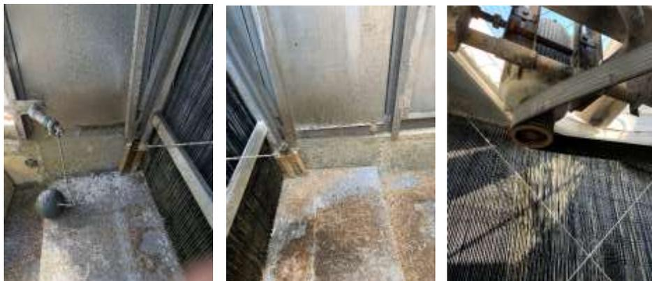
**Avant.** Corrosion à l'intérieur de la tour, ainsi que la mécanique.
